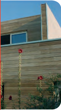
Bardage en peuplier rétifé ©Rétitech
