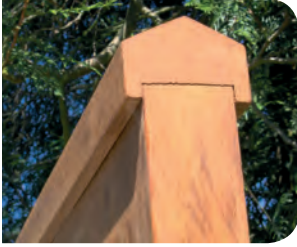
Portail en chêne conçu de façon à éviter la stagnation de l'eau ©Les Amis de la Terre/N.Marchand
